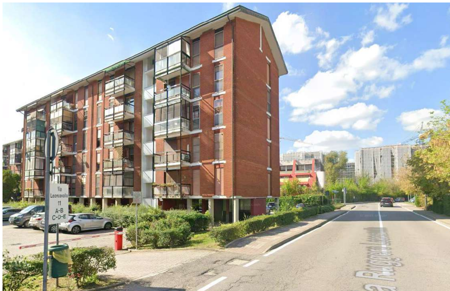
Edificio di via Leoncavallo 13 con affaccio sul civico 11
